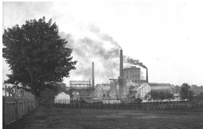
Krakowskie Zakłady Sodowe Solvay.
